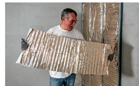
▲ Instalación del panel HYBRIS en estructura autoportante.
