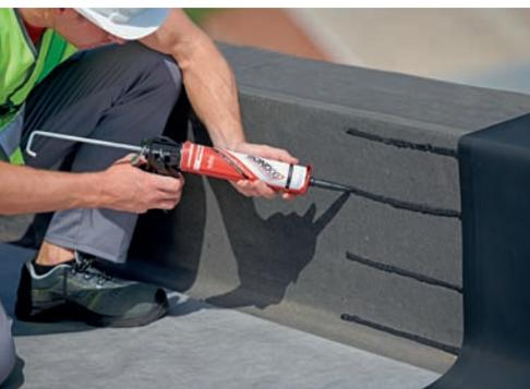
◀ Modo de aplicação com pistola de extrusão manual, pneumática ou elétrica, procurando manter o bocal à mesma altura e inclinação ao longo de todo o cordão, a fim de evitar a oclusão de ar (bolhas) e conseguir homogeneidade de adesão.
