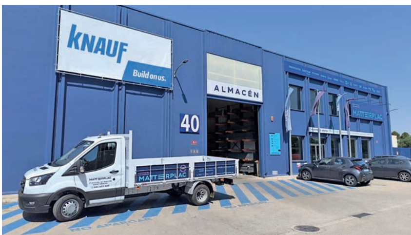
▲ Instalaciones de Matterplac en Albacete.
