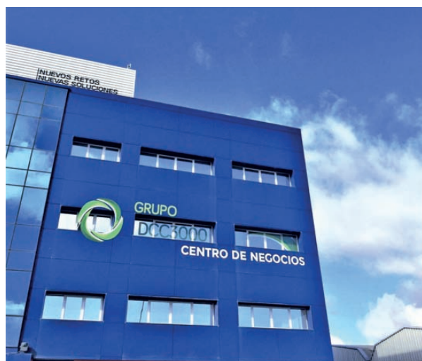
▲ Oficinas centrales de DCC 3000 en Córdoba.
