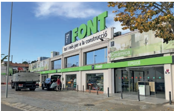
▲ Instalaciones de Materials Font en la localidad de Les Franqueses del Vallés (Barcelona)
