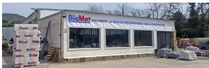
▲ Instalaciones de BigMat Calvente en la localidad de Olesa de Montserrat (Barcelona).
